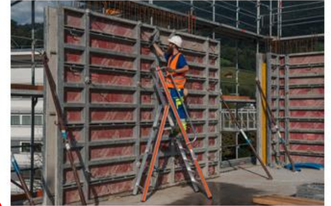
5 Arbeiten auf einer leichten Plattformleiter an einer Wandschalung
